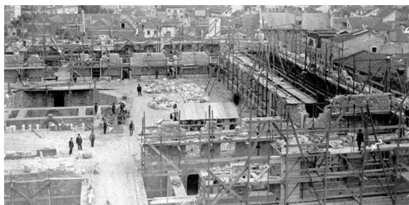
Construção do Liceu Passos Manuel
